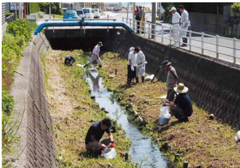
▲フルボ酸鉄を用いた水質浄化材の設置
