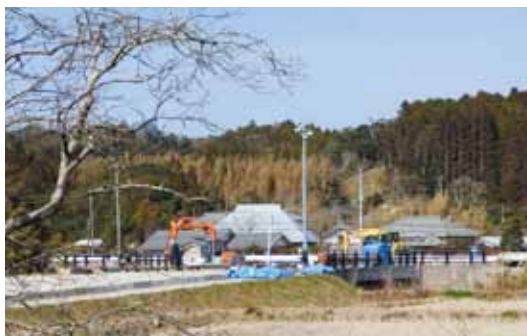
▲工事が進められている実谷バイパス
