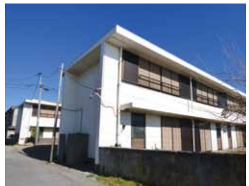
▲町営岩和田団地 安全上の観点から、令和2年度に倉庫と増築部分の取り壊しが予定されており、現在入居者の移転が進められています。 土地は御宿岩和田漁業協同組合の所有であることから、跡地を町が活用する場合は関係者との協議が必要になります。
