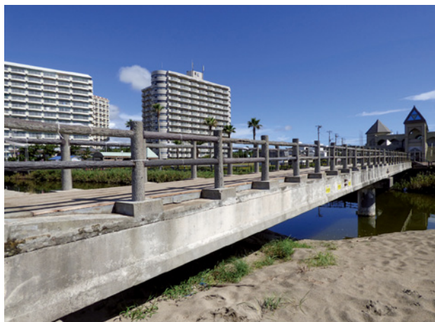
▲砂丘橋の仮設床版設置工事が完了しました。
