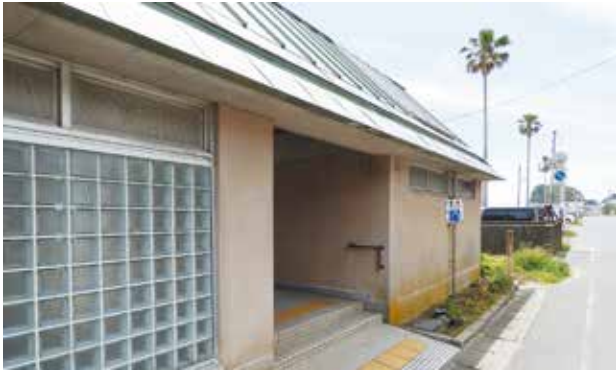
▲浜公衆トイレ
