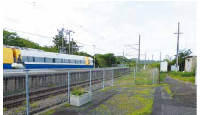
▲スロープの設置が検討されている改札口北側
