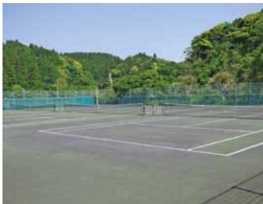
▲平成29年度に改修を予定している御宿台公園テニスコート
