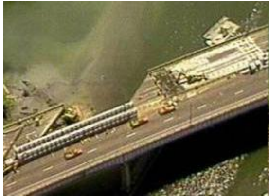
写真-1 マイアナス橋の落橋
