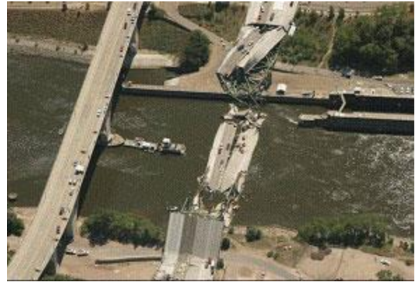
写真-2 I-35W橋の落橋（ミネアポリス橋
