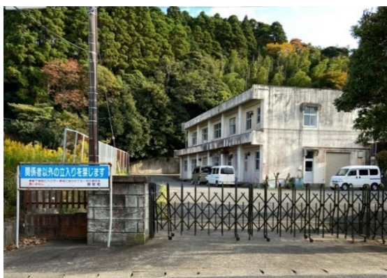
御宿町浄水場
