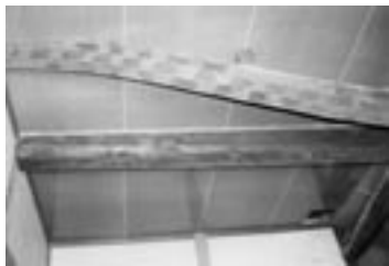
家の梁に使用されている帆柱
