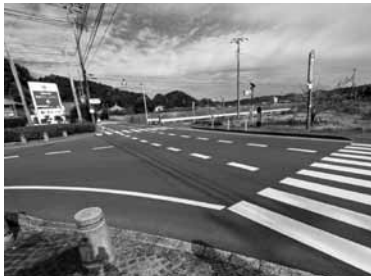
▲道路の交通安全対策を実施 (御宿台への上り口 須賀地先)
