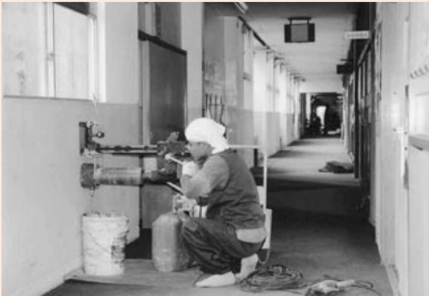
学校内の壁数箇所を採取し、耐震強度を調査します — 御宿小学校 —
