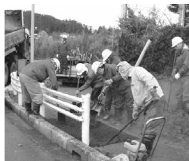
▲町道0106号線道路改良工事
