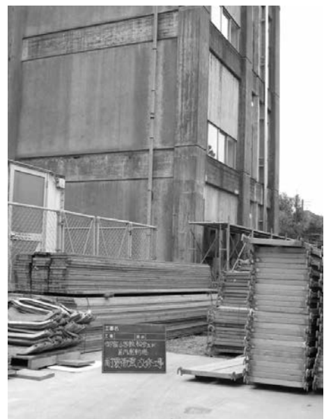
▲耐震補強改修工事が始まりました
